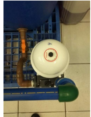
Bombas pressurizadoras
